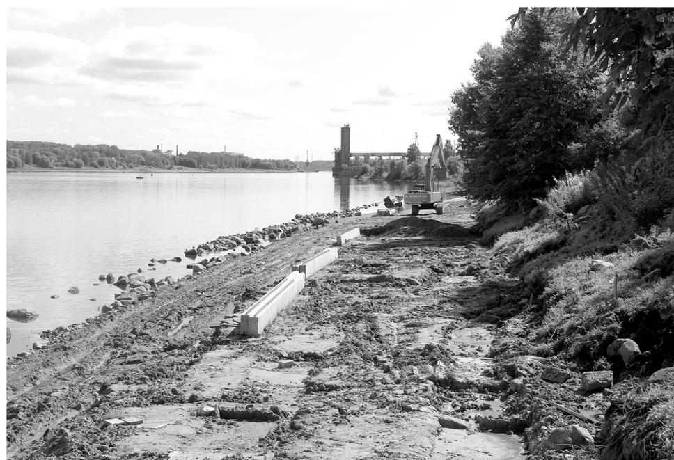
коробы могут пересекать прибывающую воду. Необходимо с помощью специалистов изучить систему, устройство самого склона и выяснить, способны ли зазоры шпунта выпустить ту воду, которая прибывает к берегу.
